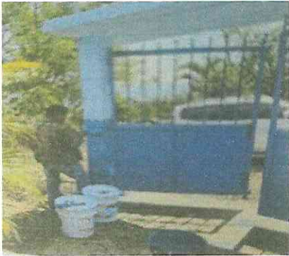
Foto 3: Mantenimiento de porton principal (limpieza, soporte y pintura)
