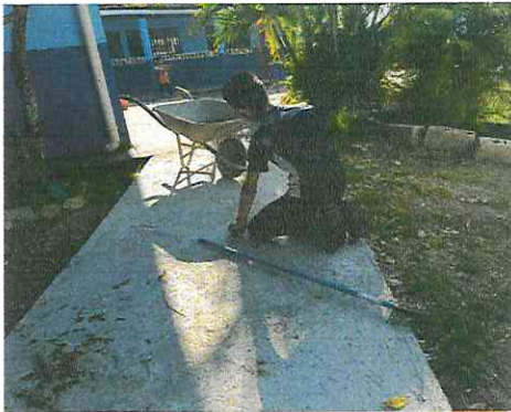
Foto 4: Sustitucion de rampa de ingreso de 2x3 de 8 cm de espesor.
