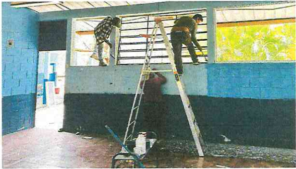
Foto1: Sustitucion de 03 ventanas tipo PVC corredizas con un alto de 1.71 mts por un ancho de 2.31 mts.
