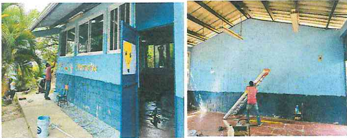
Foto 5: Colocación de pintura en aulas, cocina y baños.
